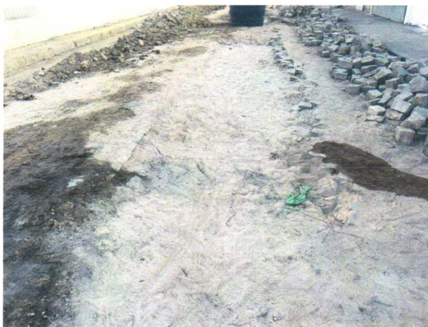
Foto 05 - ATERRO MANUAL COM SOLO ARGILLO-ARENOSO IMPORTADO E COMPACTAÇÃO MECANIZADA EM CAMADAS DE 0,20 M NO MÁXIMO
