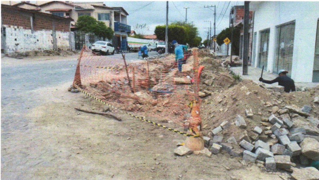
Foto 01 – Tapume de proteção em tela de polietileno h=1,20 com bloco de concreto
