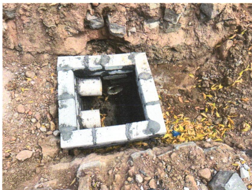
Foto 06 – ALVENARIA DE BLOCOS DE CONCRETO ESTRUTURAL 14X19X39 CM, (ESPESSURA 14 CM) FBK = 14,0 MPA, PARA PAREDES COM ÁREA LÍQUIDA MENOR QUE 6M², SEM VÃOS, UTILIZANDO PALHETA. AF_12/2014
