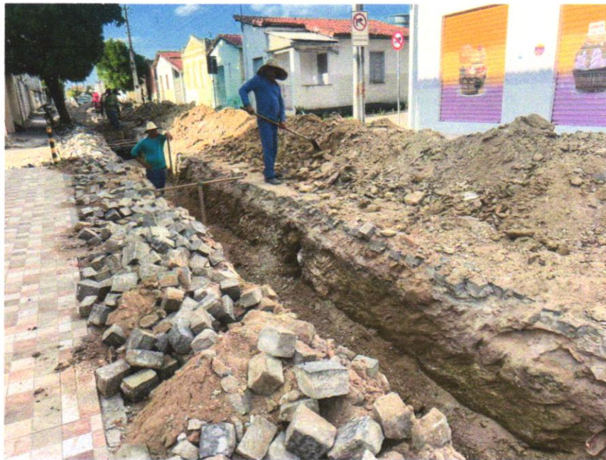
Foto 03 - ESCAVAÇÃO DE VALA
