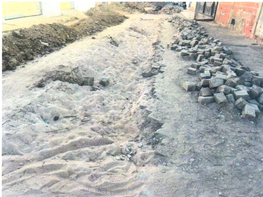
Foto 04 - ATERRO MANUAL COM SOLO ARGILO-ARENOSO IMPORTADO E COMPACTAÇÃO MECANIZADA EM CAMADAS DE 0,20 M NO MÁXIMO
