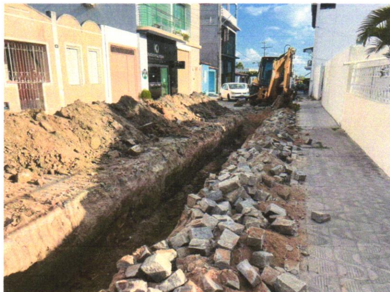
Foto 02 – ESCAVAÇÃO DE VALA
